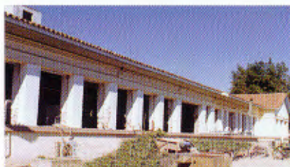
Εναρξη εργασιών ανακατασκευής του
